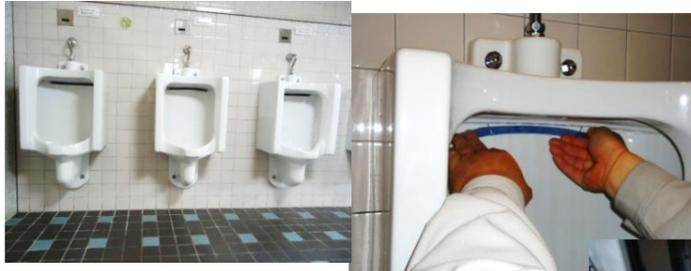
バイオプレートを取り付けます。水がでるとプレートを通水してバイオ水になって排水管の尿石が剥がれ、消臭します。
