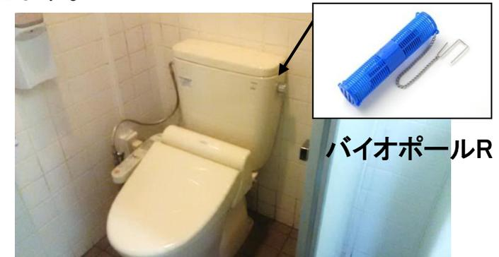
大便器は清水タンクに「バイオポールR」を投入すると「バイオ水」が溶出し、尿石の分解、雑菌の繁殖が抑制されます。
